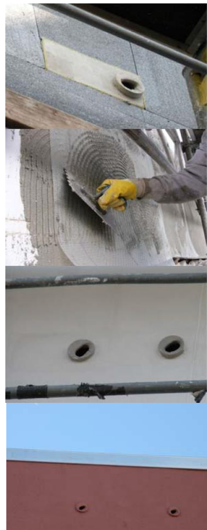
Abb. 4: Einbauschritte von Mauersegler-
